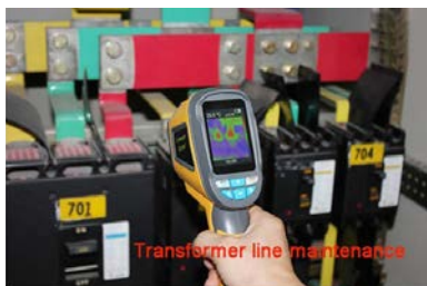
Transformer line maintenance Manutenzione della linea del trasformatore Transformer line maintenance Mantenimiento de la línea del transformador
