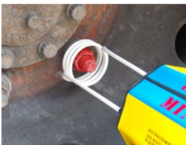
Smontaggio bulloni Disassembling bolts Desmontaje de pernos
