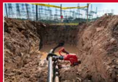
Otwarta konstrukcja szczęk ułatwia podejście do przewodu
